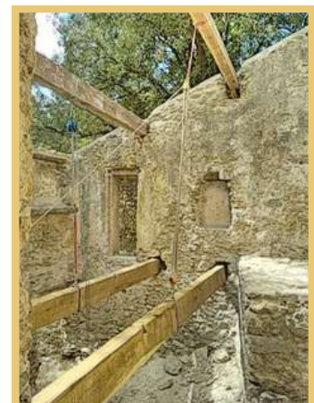
Détails de la charpente
